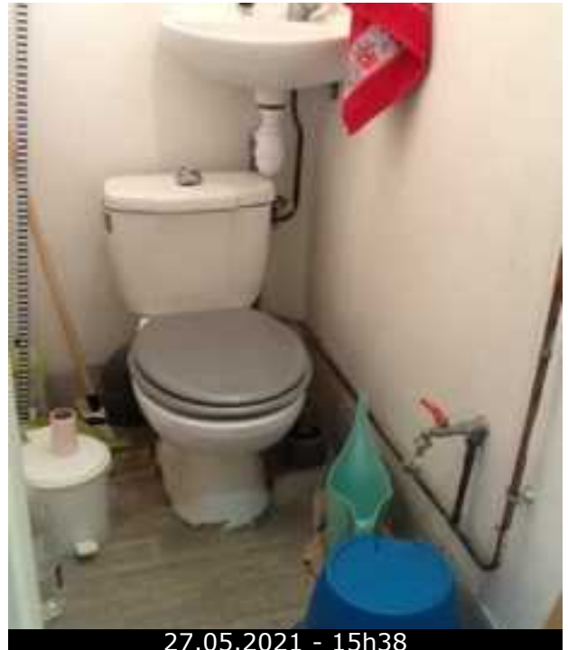
Photo 22 (Photo générale / WC)
