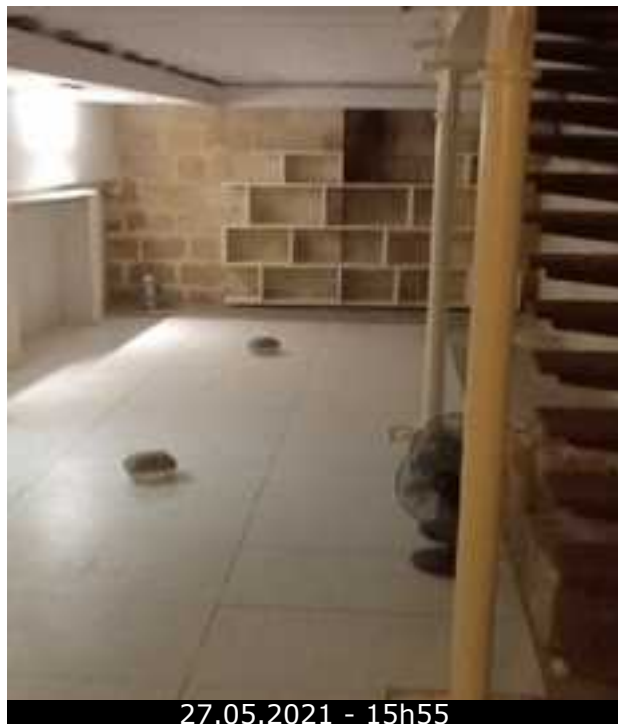
Photo 35 (Photo générale / Espace de vente 2 )
