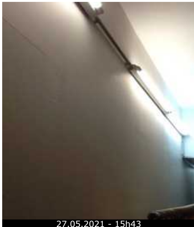
Photo 31 (Magasin / Murs / Etat d'usage)
