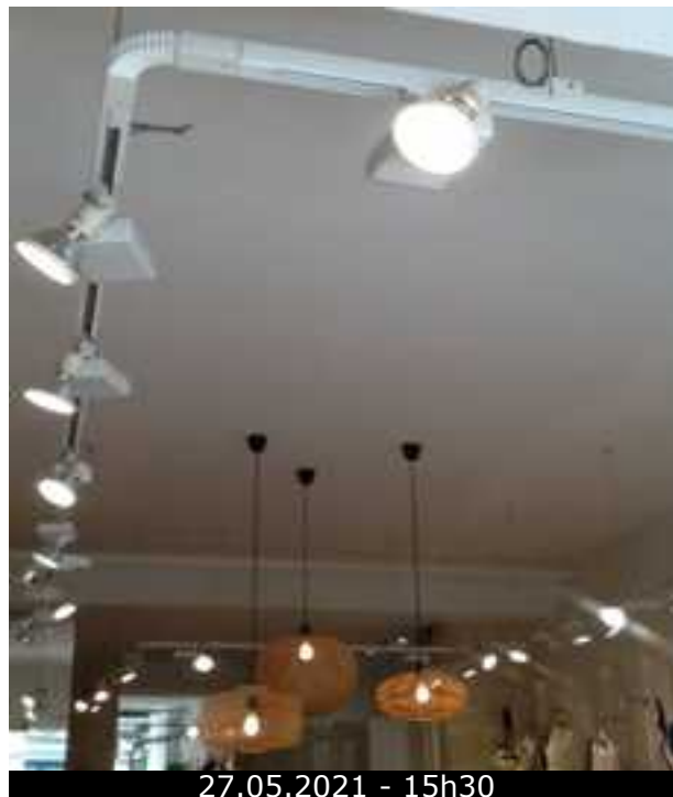
Photo 8 (Espace de vente 1 / Plafond / Bon état)
