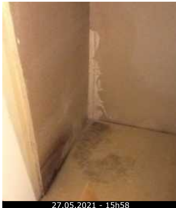
Photo 48 (Réserve 2 / Armoires / Etat d'usage)
