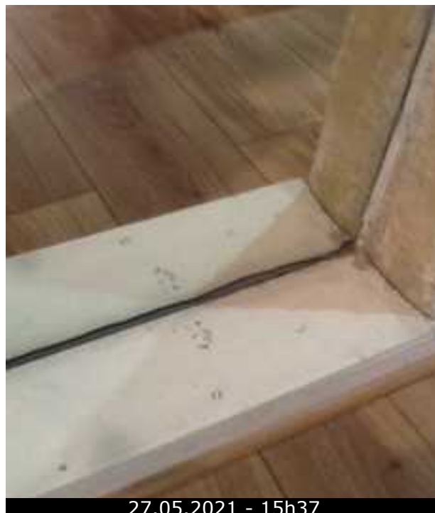
Photo 18 (Cabines d'essayage / Murs / Bon état)
