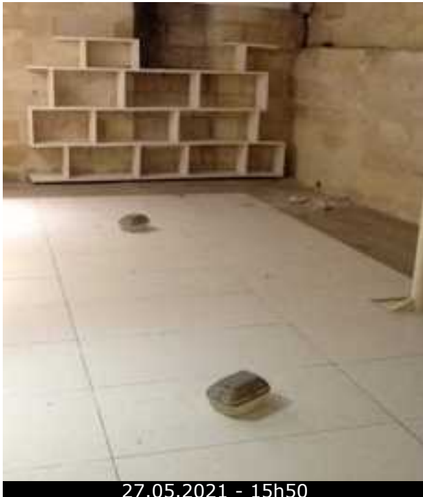
Photo 37 (Espace de vente 2 / Sol / Etat d'usage)
