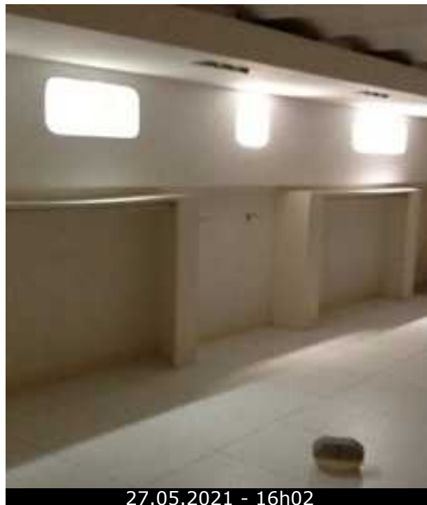
Photo 36 (Photo générale / Espace de vente 2 )
